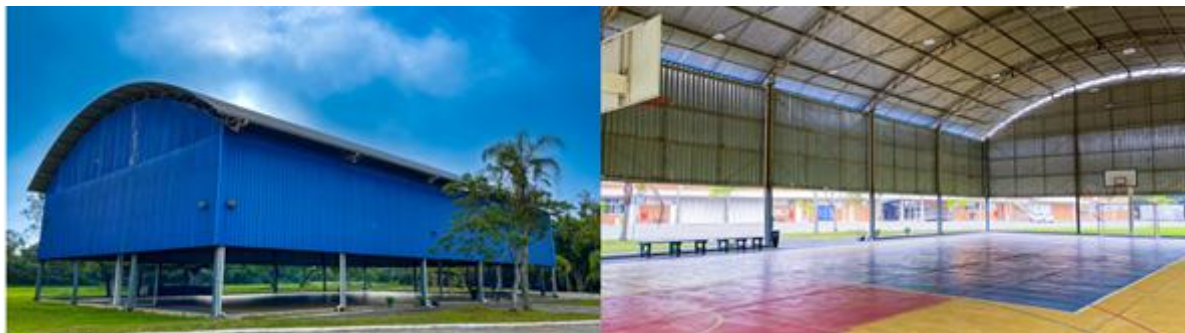
Figura 8 - Registro Fotográfico da Quadra poliesportiva coberta do campus Balneário Camboriú
